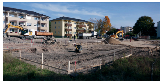
Oktober: Bodenarbeiten für das Fundament
